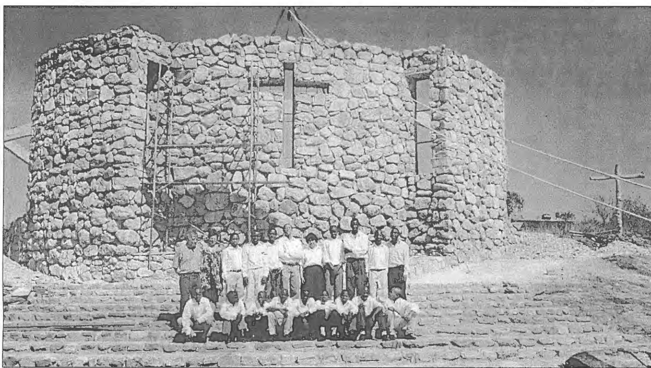
MOÇAMBIQUE — Eis o grupo que recebeu a primeira Comunhão, na escadaria da Capela da Casa do Gaiato, em construção.
